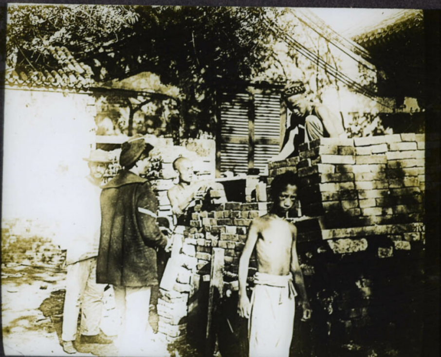
15 Construction d'une fasciade
