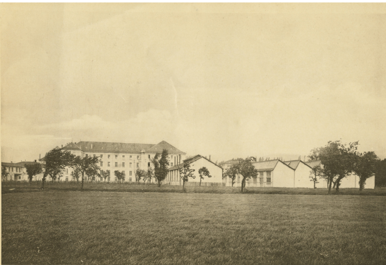
Vue d'ensemble pris vers les ateliers
