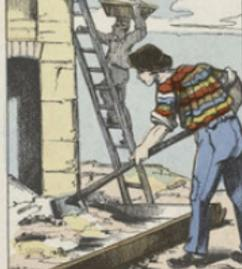
Le mortier reçoit sa principale application dans la confection des mortiers. A cet effet, on le mélange avec du sable et de l'eau dans des proportions définies et on malaxe la pâte obtenue avec un racloir. Les mortiers diffèrent comme qualité suivant les chaux employées dans leur fabrication.
