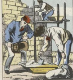
Le mortier possède la propriété de se durcir à l'air en lui empruntant de l'acide carbonique pour reformer du carbonate de calcium ou pierre calcaire. Le maçon l'étend entre les pierres dont il fait son mur et la désiccation opère entre pierres et mortier une liaison adhérente.
