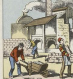
La pâte est placée dans des moules au sortir desquels la brique crue, ainsi obtenue, est mise à sécher au soleil, puis à cuire dans des fours ou étuves séparées de 20 à 25 jours. Une brique de bonne qualité doit avoir une couleur rouge-brun foncé et rendre un son clair quand on la frappe.
