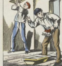
Le plâtre sert, en construction, à faire des murs à mi-chaux ou rare; partout des cloisons, des plafonds, des corniches et des moulures, des socles, etc. A cet effet, on le gâche dans une eau avec plus ou moins d'eau, de façon à en faire une bouillie ou pâte plus ou moins épaisse. Cette pâte fait prise par évaporation de l'eau, et bientôt se solidifie quand celle-ci est compléte, conservant toutes les formes qu'on a voulu lui donner.
