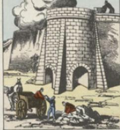
Le chaux est obtenue par la calcination, dans des fours à chaux, de pierres calcaires ou pierres à chaux. Ces pierres sont des carbonates de calcium qui, par la calcination, se décomposent en acide carbonique et en chaux. Les calcaires très purs donnent une chaux excellente dite chaux aérienne; les autres donnent des chaux de qualités diverses.
