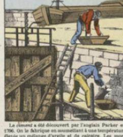
Le ciment a été découvert par l'Anglais Parker en 1796. On le fabrique en soumettant à une température élevée un mélange d'argile et de calcaire. Les mortiers de ciment sont très employés dans les constructions qu'on veut obtenir sèches plus ou moins rapidement — dans tous les cas plus rapidement qu'avec le mortier de chaux — ciment à prise lente ou rapide; ou celles qui doivent être exposées à l'humidité : ciment hydraulique.
