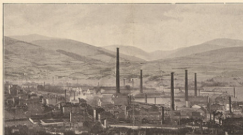
La vie industrielle Vue générale des Forges et Ateliers de la marine à Saint-Chamond.
