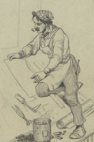
Z Zinc mis en place de plomb pour couverture de bâtiments.
