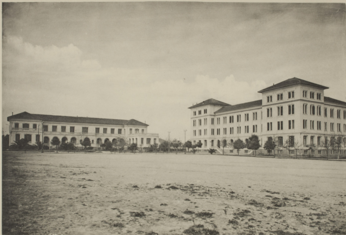
Bâtiment d'Enseignement, Internat, Terrain de Sport (2)
