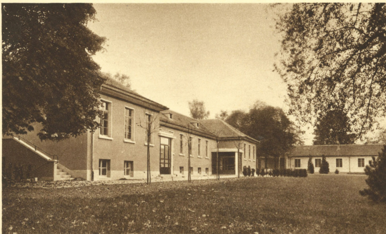
1. ÉCOLE DE PLEIN AIR — FAÇADE
