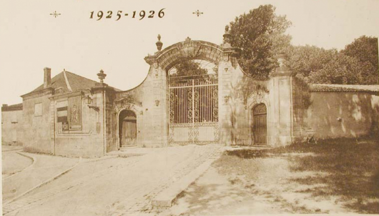
Porte d'entrée (Monument classé)
