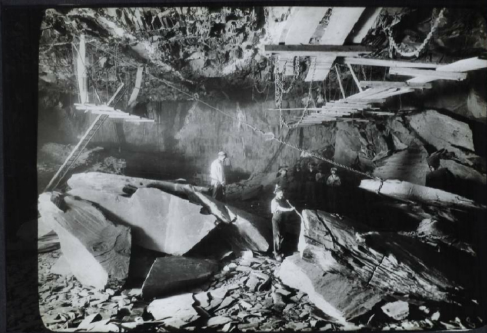
Déplacement des blocs abattus à l'aide des treuils électriques N° 9 J.E. BULLOZ, Editions Photographiques, 21, rue Bonaparte, PARIS
