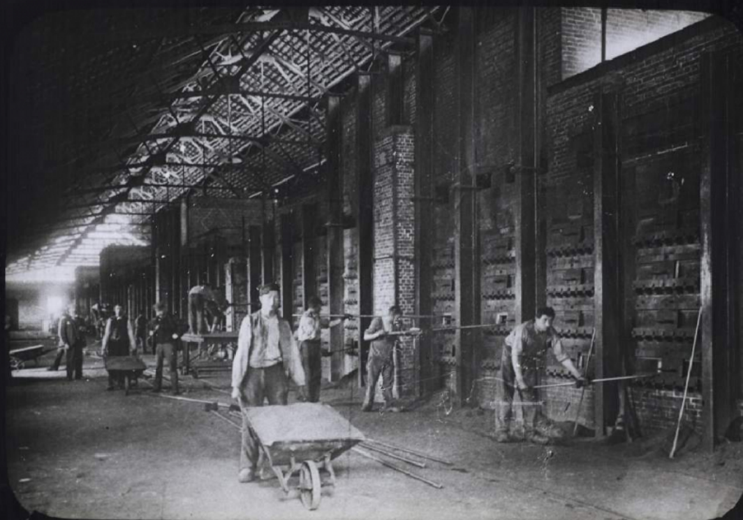
4 Hall des fours de grillage
