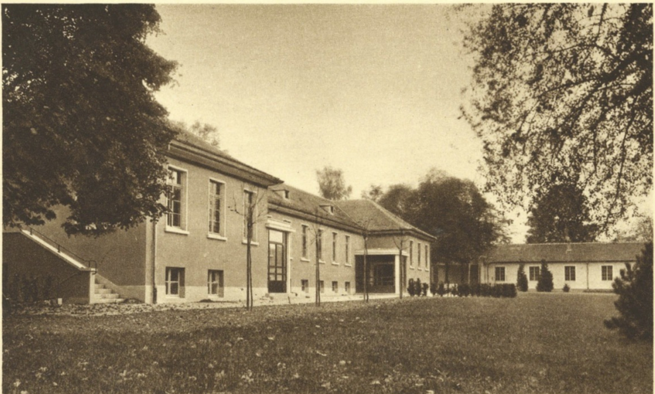
1. ÉCOLE DE PLEIN AIR — FAÇADE
