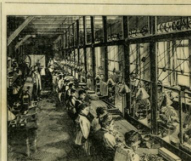
Fig. 6. — Ateliers de l'elanche, c'est-à-dire de la préparation des différentes pièces des montres, dans une fabrique moderne d'horlogerie.
