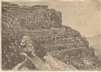
route de la corniche à constantine
