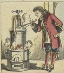
En 1681, Denis Papin inventa une MARMITE à cuire la viande et les os au moyen de la vapeur concentrée dans un vase clos. Pour pouvoir suivre la cuisson des viandes dans son DÉGESTEUR, il y fit un trou qu'il boucha avec une soupape. Tel est l'origine de la célèbre soupe de bœuf de sûreté des chaudières à vapeur.
