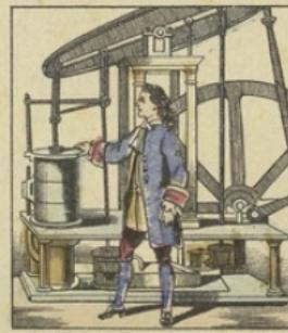
En 1765, James Watt crée définitivement la machine à vapeur telle que nous la connaissons. Au lieu d'employer le vide et la pression de l'air, il emploie la vapeur comme moteur sur les DEUX FACES du piston : il inventa le condenseur, la pompe à air, le régulateur, le parallelogramme articulé, etc. etc.
