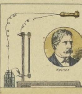
Heureusement, la découverte du **microphone** due à Hughes, vint fournir un transmetteur bien plus puissant ; de sorte qu'on appelle aujourd'hui téléphone un dispositif dans lequel sont combinés le transmetteur microtéléphonique de Hughes et le récepteur magnétique de Bell ou, plus exactement, des dérivés de ces appareils.
