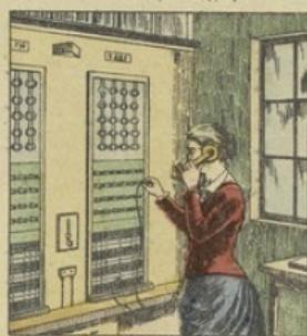
Dès 1876, des communications téléphoniques furent installées avec ce téléphone magnétique. Mais, en pratique, on portée se trouva restreinte à quelques kilomètres, à raison de la présence de courants anormaux sur les fils conducteurs.
