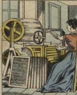
On fabrique également des ALLUMETTES-BOUGIES. Dans ce cas, les petites bâchettes de bois sont remplacées par des bouts de tresse de coton sans fin, que l'on fait passer dans un bain de cire fondu, en qu'une machine spéciale coupe en bouts de 5 centimètres.
