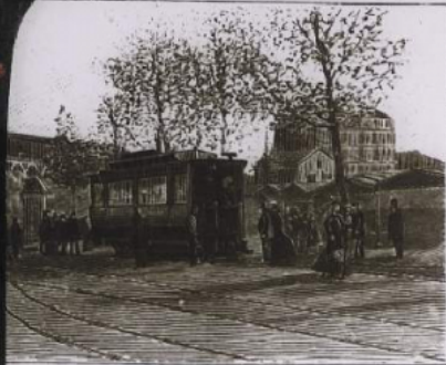
Station terminus place de la Bastille, à Paris.
