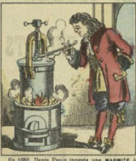
En 1684, Denis Papin invente une MARMITE à cuire la viande et les os au moyen de la vapeur et de la pression. C'est ainsi qu'il réussit à cuire les viandes dans son DIGESTEUR, il fit un trou qu'il boucha avec une soupe. Telle est l'origine de la célèbre soupe de sûreté des chaudières à vapeur.
