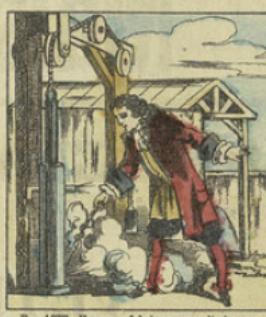
En 1672, Huygen fabriqua un cylindre muni d'un piston sous lequel il faisait détoner de la poudre à canon. Le piston s'élevait brusquement : on formait le vide au-dessous de lui, et alors, chaussé d'une gaine étanche à l'air, le piston redescendait dans le cylindre entraînant après lui des poids ou l'eau d'un puissant.
