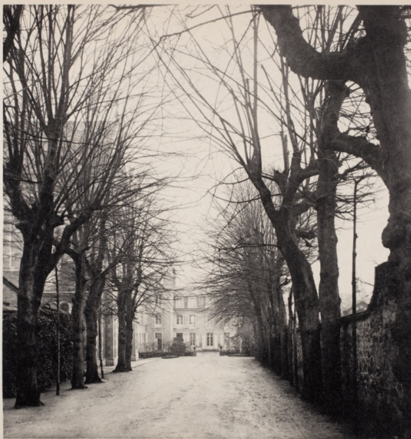
Entrée Grande Avenue 41
