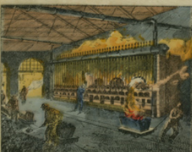
Fig. 10. — Usine à gaz. A gauche, l'arrivée de la houille; à droite, les cornues; l'enlèvement du coke incandescent.
