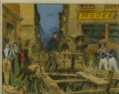
Fig. 9. — La pose des premiers tuyaux à gaz. — La foule, hostile au nouvel éclairage, ne cache pas la répugnance que lui inspire l'odeur du gaz.
