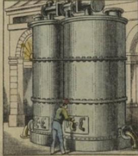
Puis le gaz est soumis à d'autres opérations, car sa pureté fait sa qualité. On des appareils les plus variés, on obtient des gaz très purs, nommés COLONNES pleines de briques pilées chargées de produits chimiques à travers lesquels le gaz se divise et se filtre.
