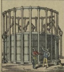
Le gaz, une fois purifié et propre à l'éclairage, se rend dans une cloche creuse renversée sur de l'eau et qu'on nomme GAZOMÈTRE. Le gaz fait monter la cloche en s'y introduisant pendant le jour. Le soir, quand on allume le gaz partout dans la ville, le gazomètre se vide et la cloche s'abaisse en poussant le gaz dans les tuyaux de conduite à travers les rues et les habitations.
