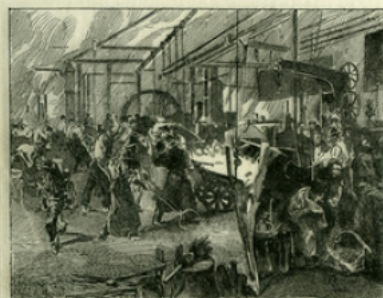
Fig. 10. — Usine Krupp à Essen : fonderie de l'acier.
