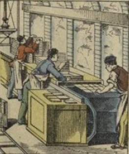
Le Chocolat, moulé à l'état pâteux et chaud à becquet, pour se démolir, d'être solidifié par un refroidissement dans un arrosoir, dont les toiles fines se mouvent dans des conduites renfermées d'air froid et de l'invention brevetée de MM. LOMBART et BILLAUDOT, sont chargées de moulés remplis de chocolat, et le refroidissement s'y opère avec une rapidité extrême.
