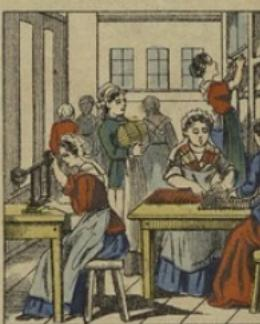
Pour cela, on colore et puis on vernit chaque crayon de façon à lui donner l'aspect coquet et brillant que nous lui voulons. Lorsque sa forme est terminée, l'ouvrière y imprime la marque du fabricant. Ainsi habillé et décoré, le crayon est prêt pour la vente.
