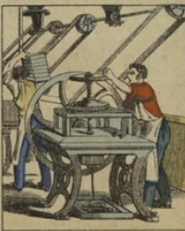
Cette poussière de graphite est mélangée en proportions variables, suivant le degré de dureté qu'on desire obtenir, avec de l'argile palévrise. La pâte ainsi composée, est soumise à une machine qui la fait sortir sous forme de fil rond ou carré.
