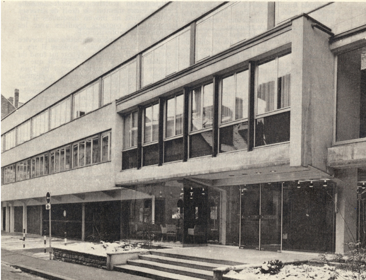
Rectorat de l'académie de Strasbourg. Façade nord, rue de la Toussaint. (Photo C. R. D. P. Strasbourg.,
