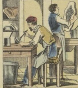
Lorsqu'on a le moule de guta, on le recouvre avec un pinceau d'une légère couche de pléomagnie destinée à le rendre conducteur du courant. Le pléomagnie s'applique avec un grand succès sur les formes les plus délicates sans amener l'engorgement des détails ni la déformation du modèle.
