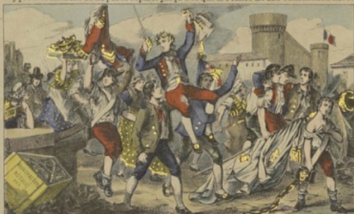
Démolition de la Bastille.
