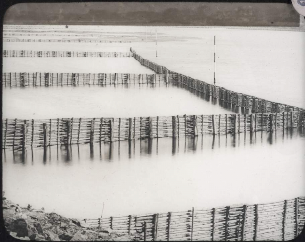
Savennières. Barrages de la Loire
