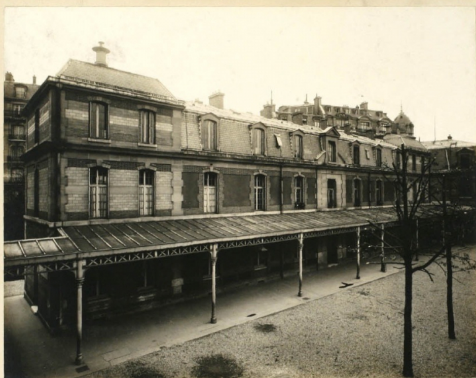
16 - Sanitons de l'infirmerie
