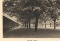
Vue des Cours
