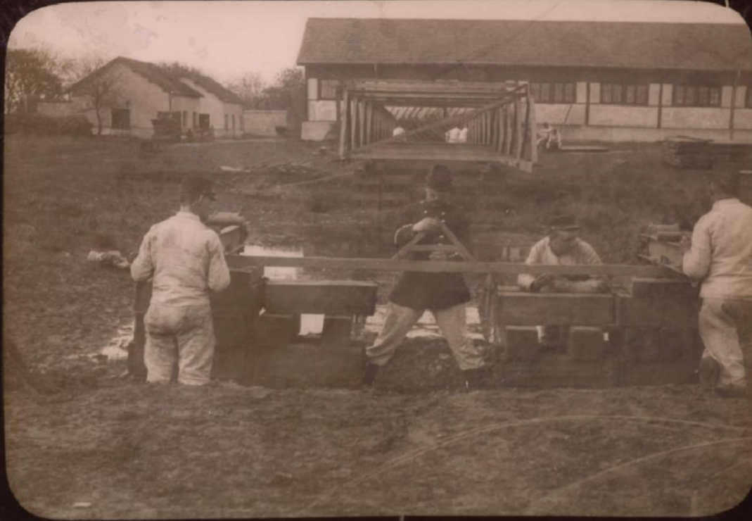
20532 Construction des decalage des piles
