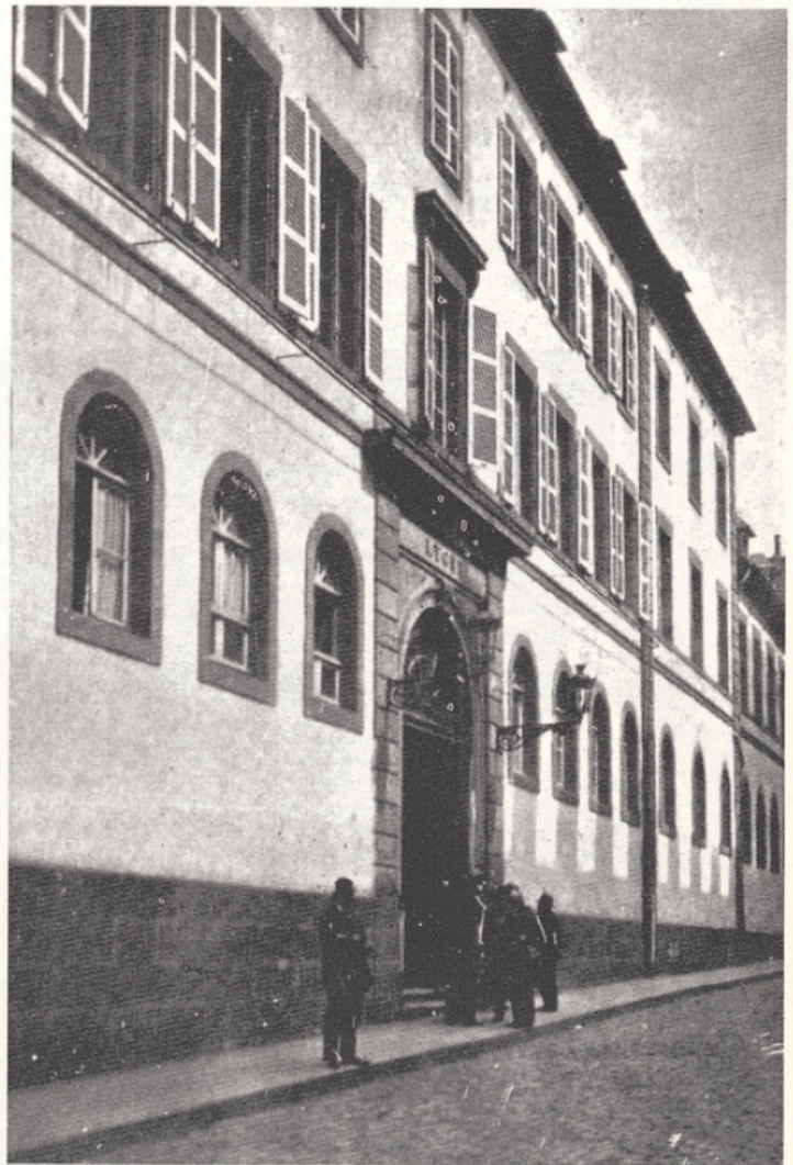
Porte d'entrée du Lycée
