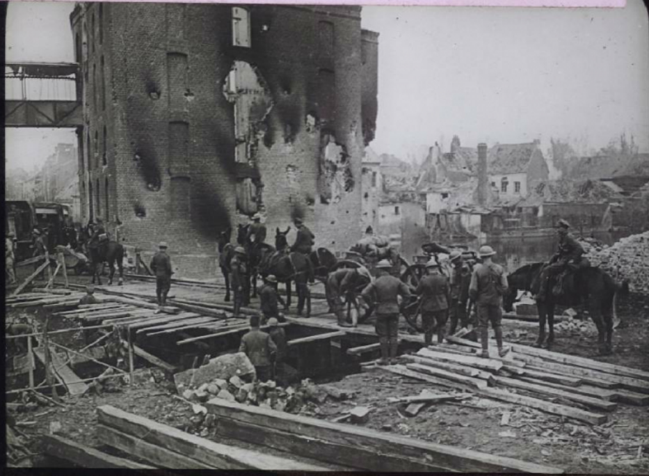
12 - Nord - Valenciennes Passage construit au-dessus d'un entonnoir de mine
