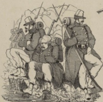
Garde de Tranchée.
