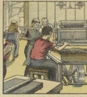
Après nouveau triage, les amandes sont broyées et réduites mécaniquement en une pâte semi-liquide par addition progressive de la quantité d'eau nécessaire. A cette pâte s'ajoute alors le sucre raffiné, opération qui se fait dans des mélangeurs, vases en fonte à fond de granit dans lesquelles tournent deux cônes tronqués en granit. Le mélange intime opéré, on soumet encore la pâte à un dernier broyage en ajoutant de la vanille ou autres aromates.
