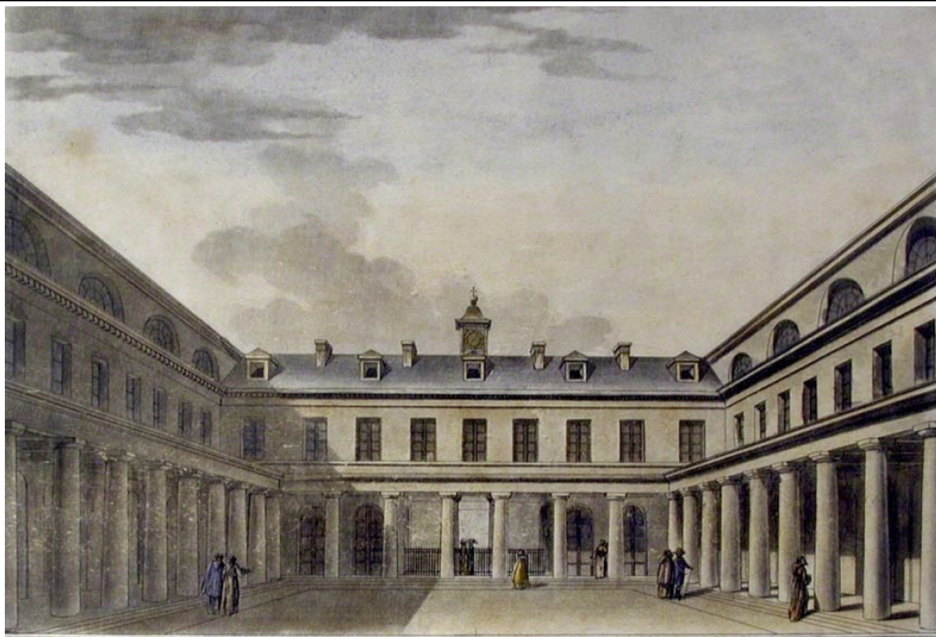
ENTRÉE DU LYCÉE BONAPARTE, (Ci-devant Cloître des Capucins, Rue S te Croix Chaussée d'Antin)
