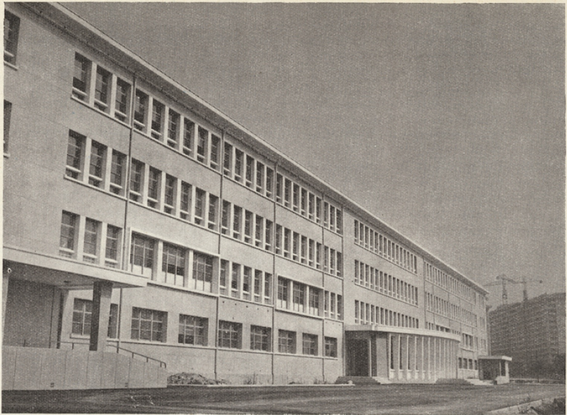
... Les orienteurs devraient avoir rapidement à leur disposition toute la gamme des écoles voulues ... Ici, le lycée technique d'Etat de jeunes filles de Lyon, bâtiment d'externat.
