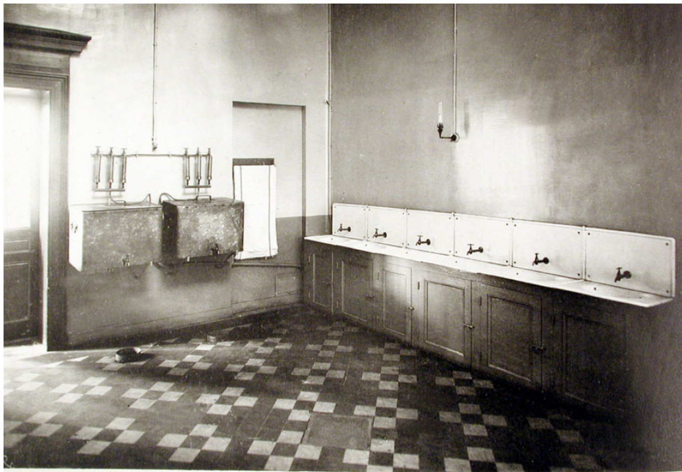
Vestibule du Réfectoire. - Lavabos et Filtres
