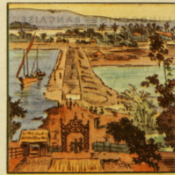
DIGUE DE PROTECTION A CHAN-MÉ GONG/ANNAM
