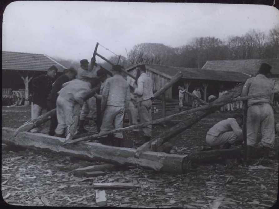
20281 Construction d'un chevalier XX
