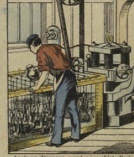
Après un décapage ayant pour objet d'enlever toute tache de graisse et d'oxydation, chaque pièce est plongée, suspendue par un fil de cuivre, dans le bain d'argenterie. De nombreuses machines électro-magnétiques GRAMME, remplaçant l'action de la Pile, décomposent les bains métalliques dont l'argent se dépose sur chaque couvert.
