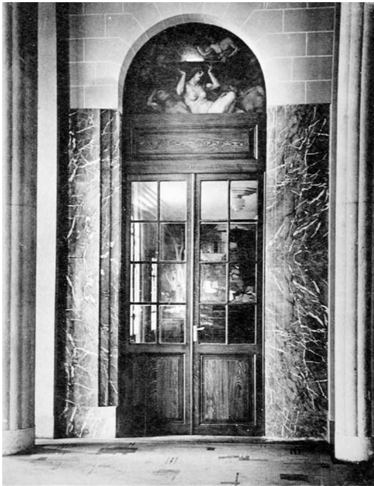
Vue du Hall côté droit
