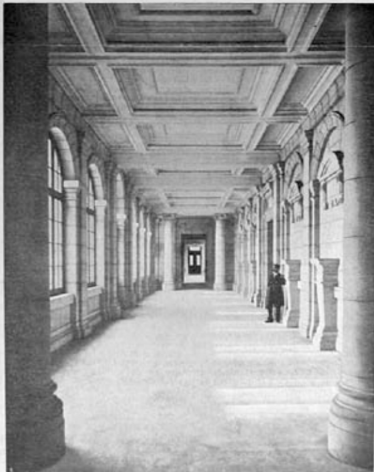
La galerie de surveillance. — Fiat, A. Geyss.
