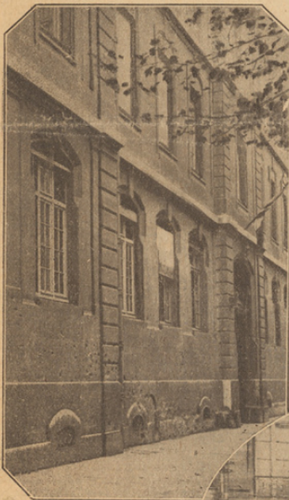
LA FAÇADE DU BOULEVARD SAINT-MICHEL QUI FUT RAVAGÉE PAR DES BOMBES DE GOTHAS.
