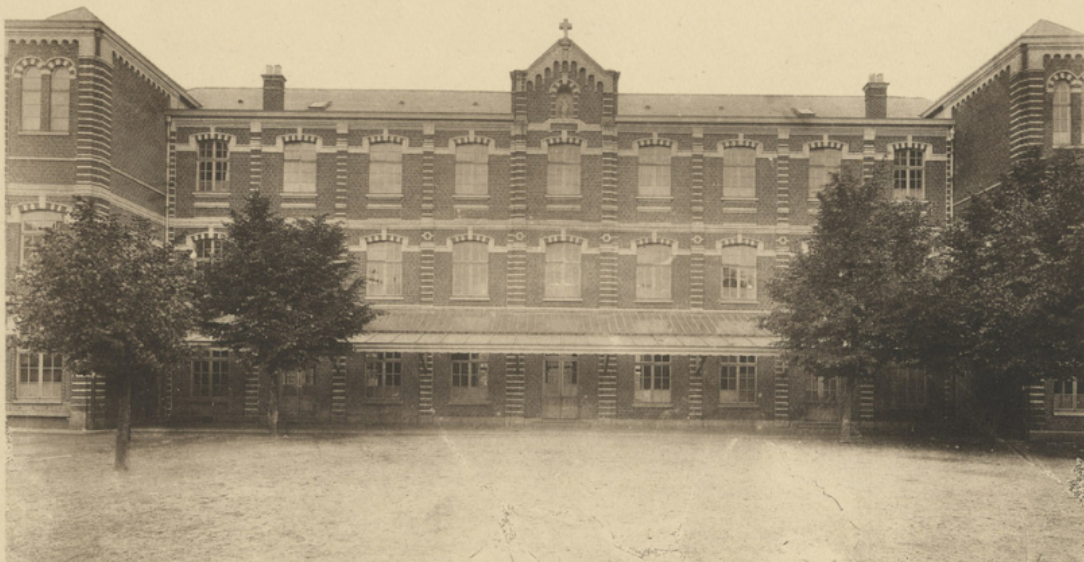
Grande Cour — Bâtiment principal 21
