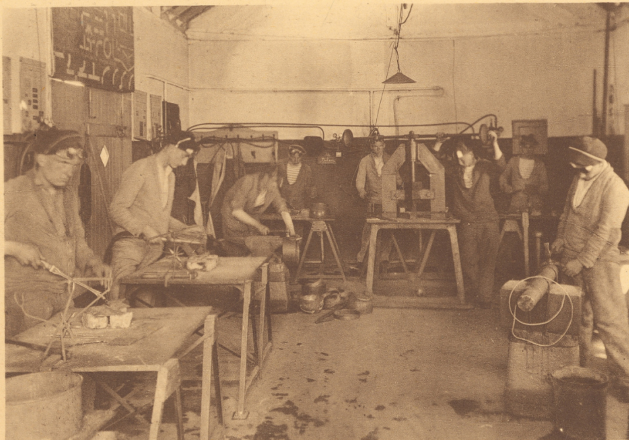
Ateliers : Soudure autogène.
